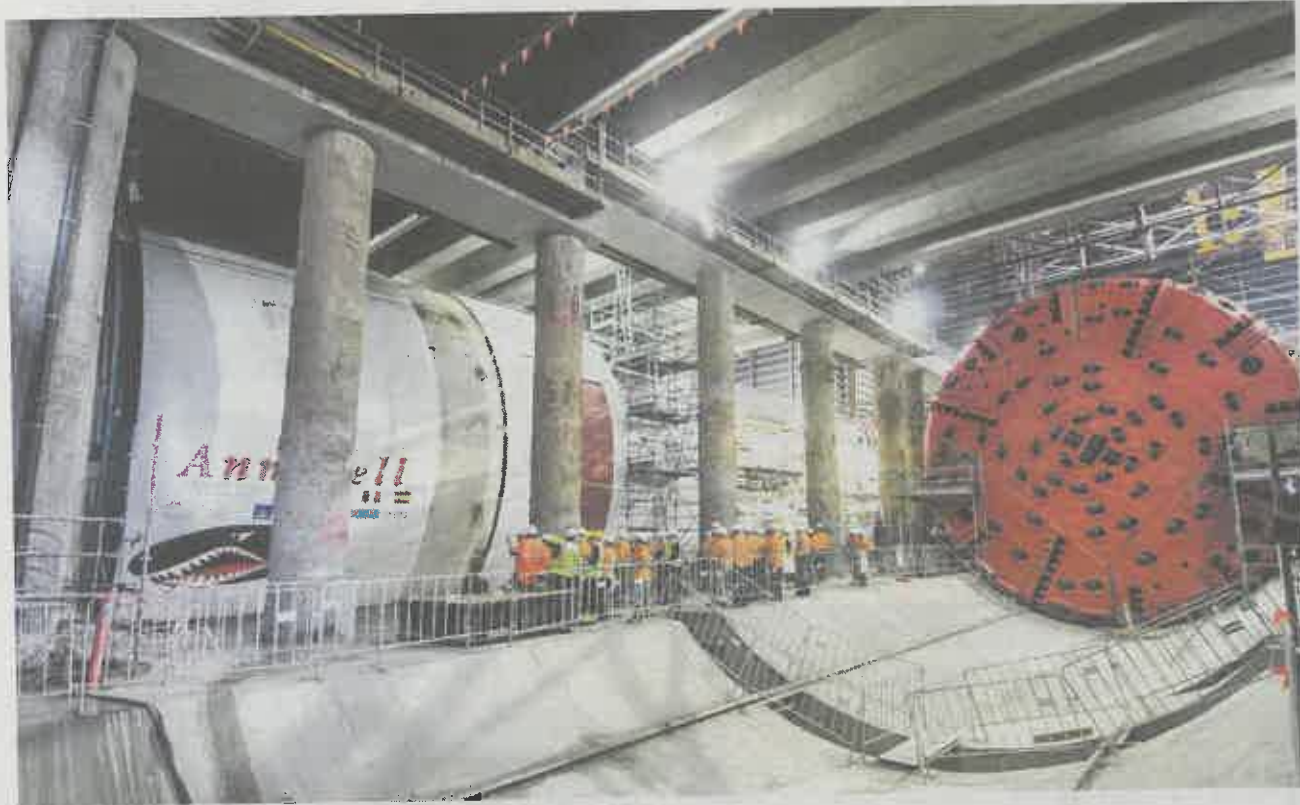
Interior del Túnel Legacy Way, en Brisbane, Australia.
