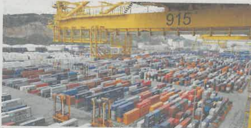
La Terminal de Contenedores de Barcelona (TCB) ha ampliado sus instalaciones en el muelle sur.
