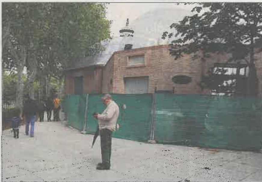
Estado de las obras del recinto, situado en el parque de El Retiro. ÁNGEL NAVARRETE
