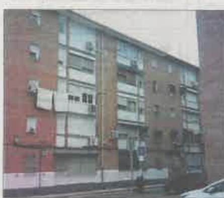
Uno de los dos edificios que se rehabilitarán. E.M.
