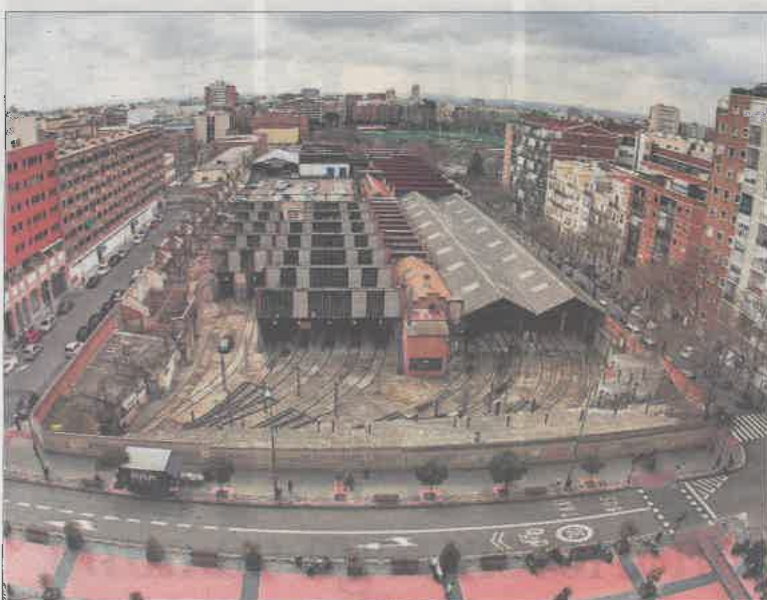
Vista de las cocheras de Cuatro Caminos, en el distrito de Chamberí. ALBERTO DI LOLLI
