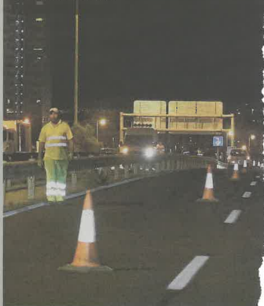
Un operario cierra el tráfico en el nudo norte, el primer día de obras
