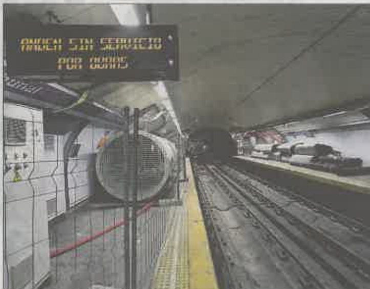
Trabajos en la estación de Tribunal. / K. P.
