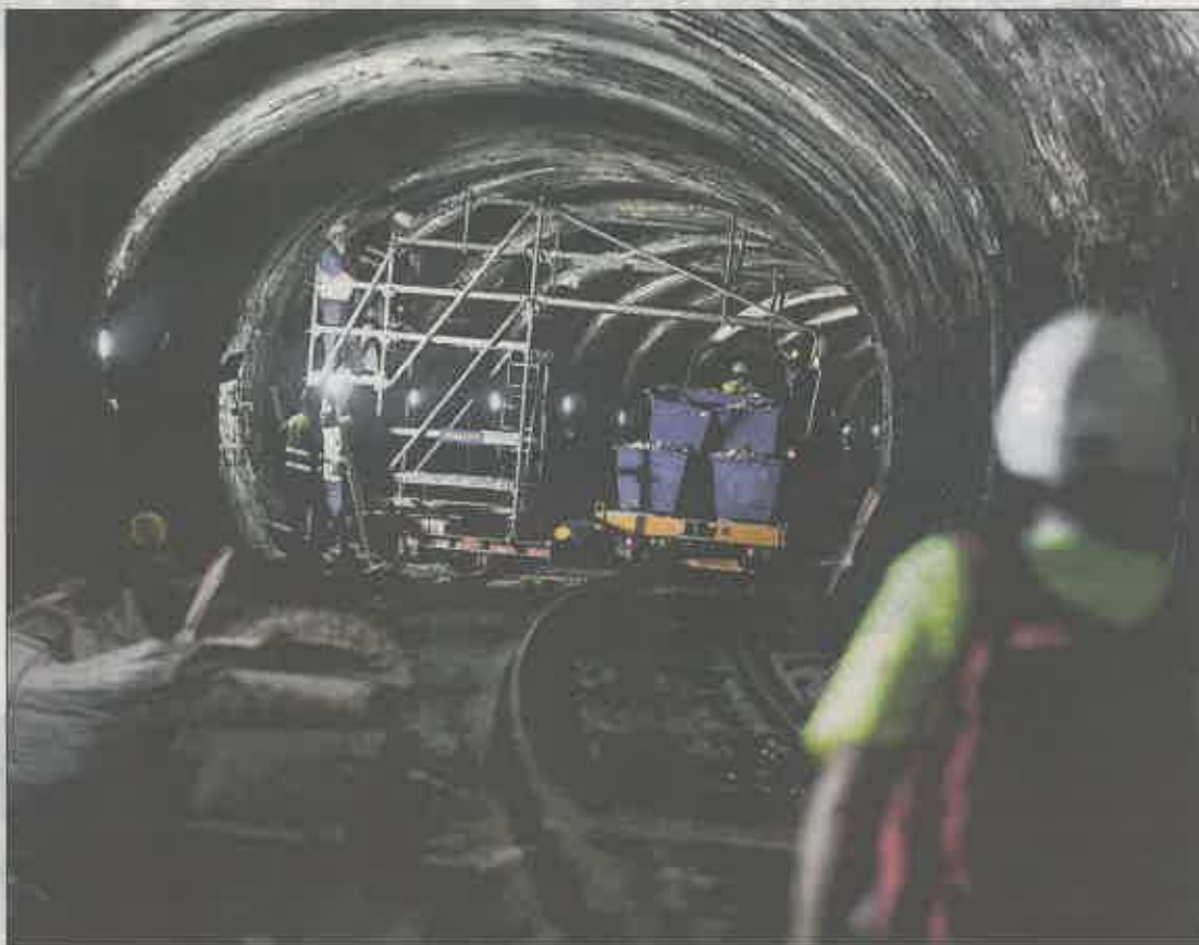
Estado de las obras de remodelación de la línea 1 de Metro de Madrid, ayer. / KIKE PARA
