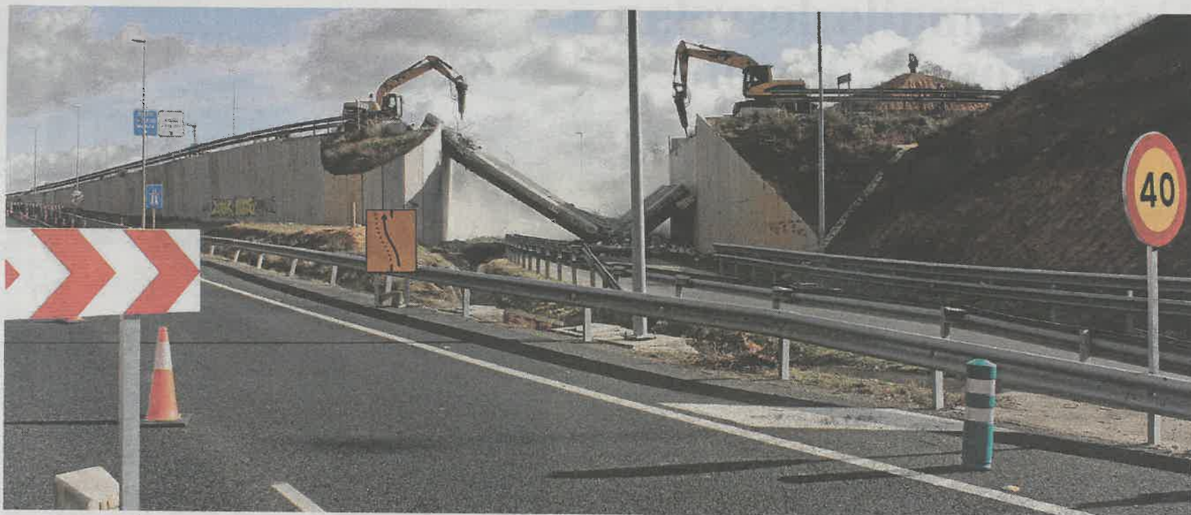
Obras realizadas en el acceso a la carretera de Azucaica y Mocejón (Toledo)
