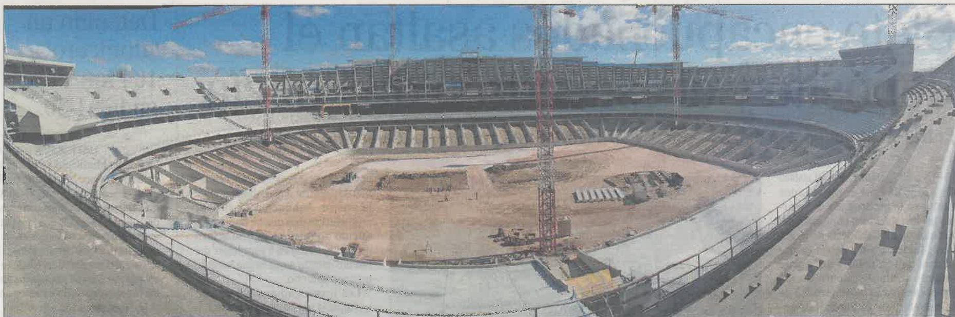
Panorámica del interior de las obras de construcción de La Peineta en donde el Atlético de Madrid disputará sus partidos de fútbol. E.M.
