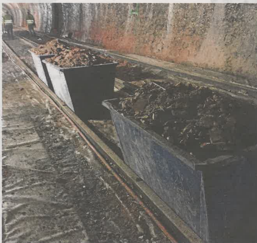
Carretillas con el material retirado de las paredes del túnel
