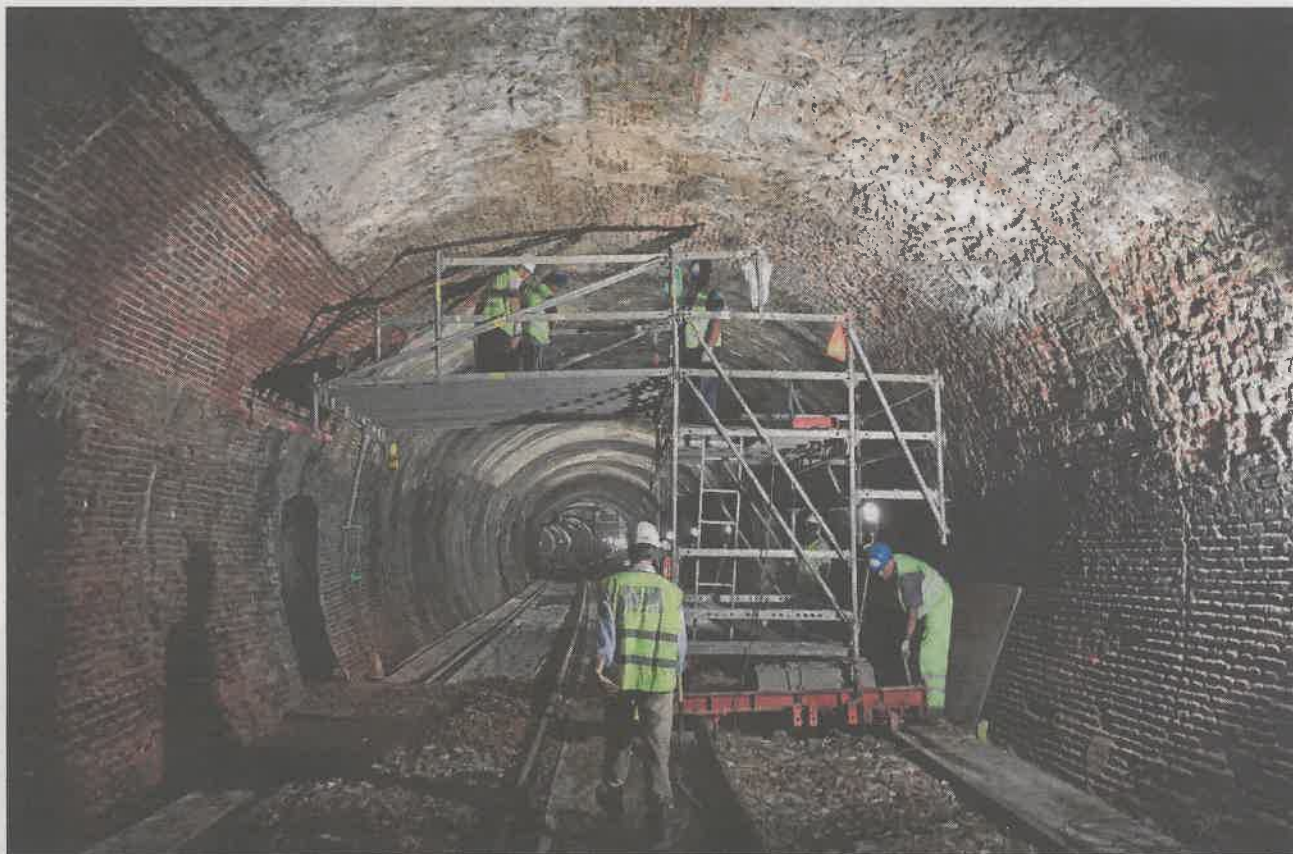
Interior de un túnel de la línea 1, donde se aprecia la mezcla de materiales utilizados en la bóveda
