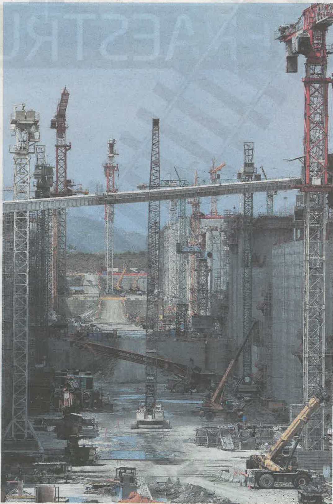
Las obras de ampliación del Canal de Panamá requirieron siete años de trabajo. /RODRIGO ARANGUA/ AFP/ PH/ AML
