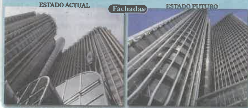
La apariencia exterior del edificio cambiará totalmente después de recubrir de acero texturizado los pilares de hormigón en forma de nervios, tan característicos del edificio
