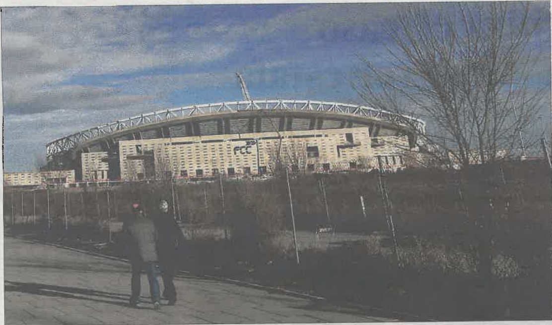
Obra en el estadio Wanda Metropolitano el pasado mes de diciembre. / ÁLVARO GARCÍA
