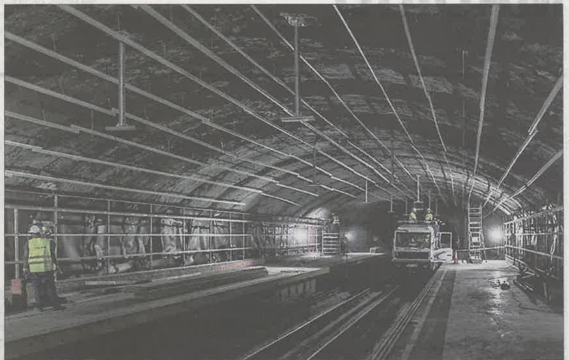
Varios operarios trabajan en las obras de acondicionamiento de la línea 5. / COMUNIDAD DE MADRID
