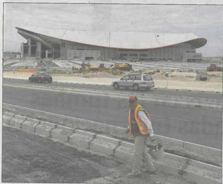
Obras de acceso al estadio Wanda, el pasado domingo. / VÍCTOR SAINZ
