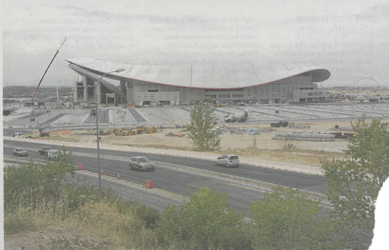
Obras en los accesos, el aparcamiento y el Estadio Wanda Metropolitano
