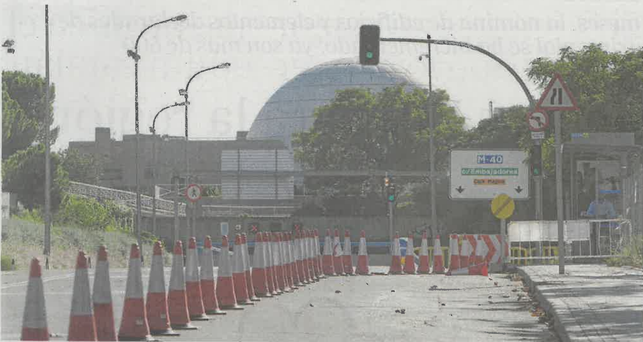
Acceso al túnel de la avenida del Planetario cortado ayer
