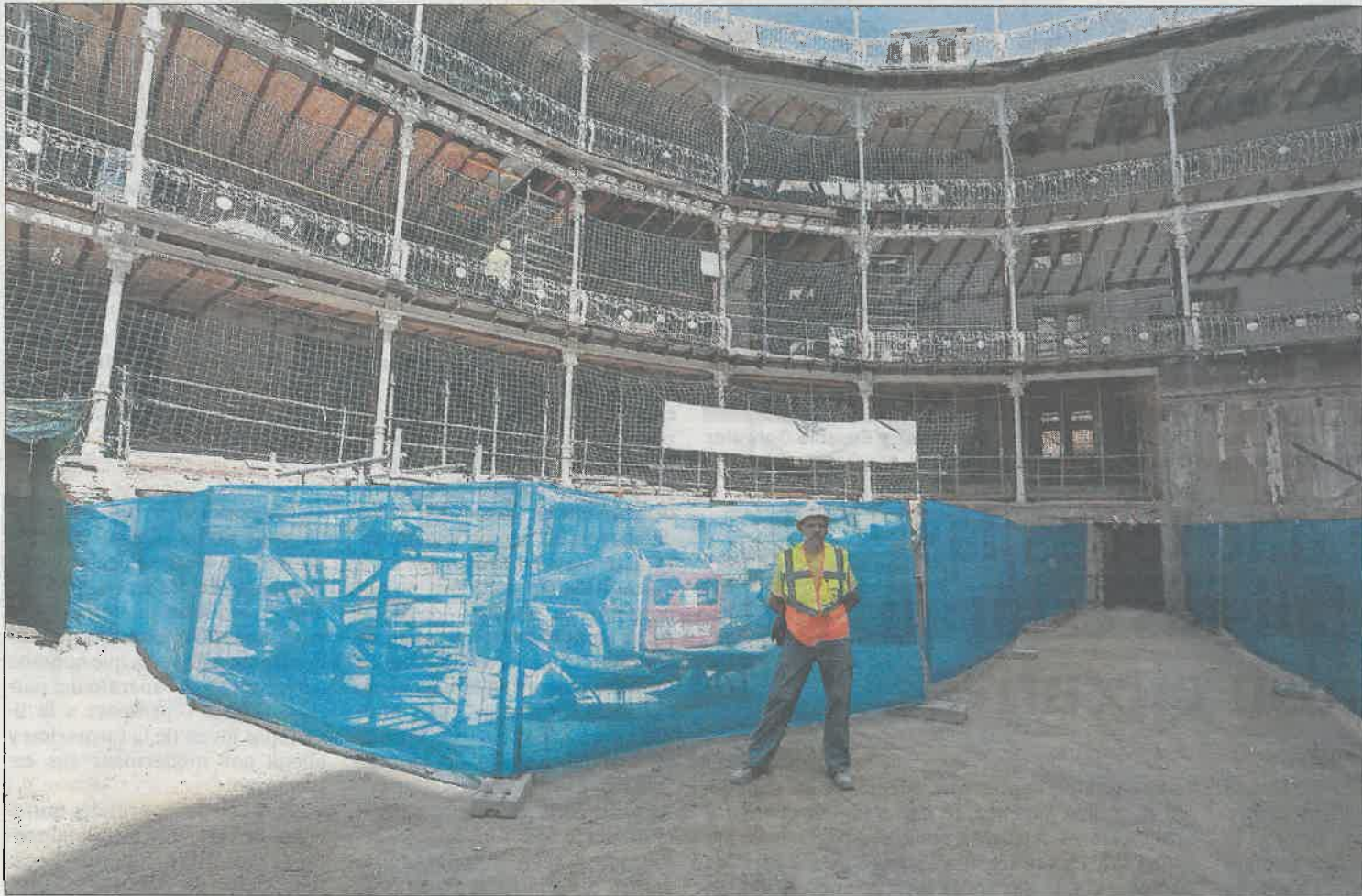
Estado de las obras en el interior del frontón Beti Jai, el pasado mes de mayo. / KIKE PARA
