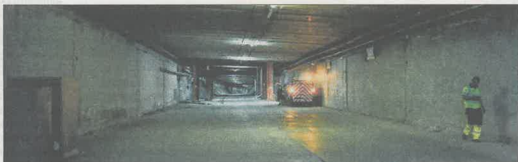
Túneles de evacuación de la M-30. BERNARDO DÍAZ
