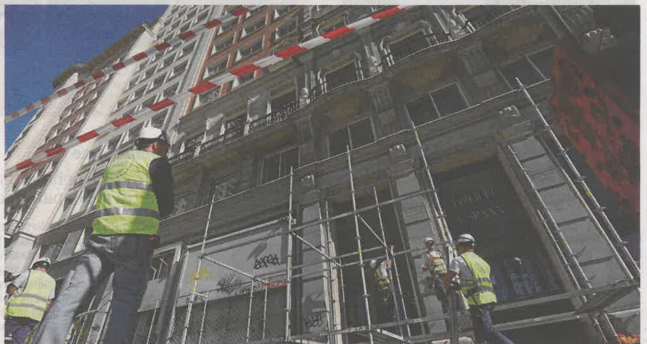
Varios trabajadores colocan los andamios, ayer, en la fachada del Edificio España MAYA BALANYA
