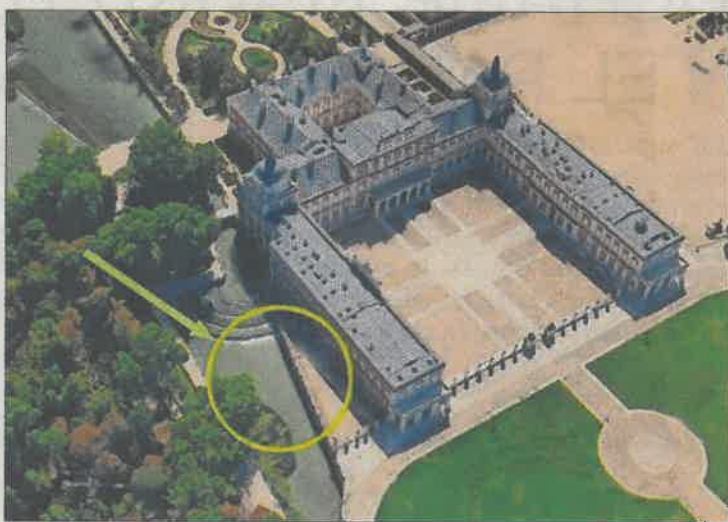
Zona afectada por el desgaste del muro.
