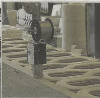
A la izquierda, el proyecto de urbanización de casas en 3D. Arriba, el brazo robótico que emite un cemento especial para la construcción de la vivienda
