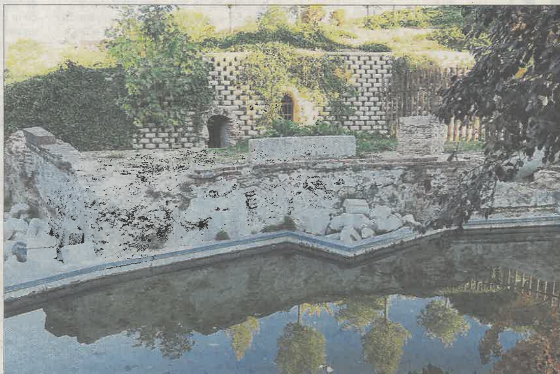
Entradas al viaje de agua de Amanuel, que está siendo rehabilitado. / AYTO. DE MADRID
