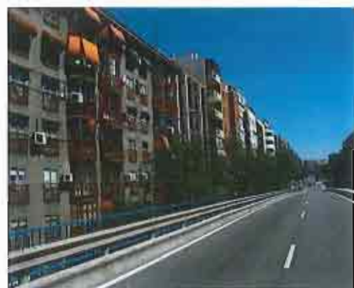
Vista de los edificios con problemas de ruidos (lateral derecho)
