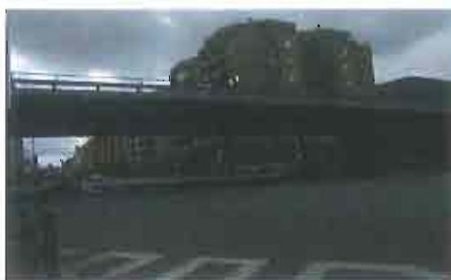
Vista del viaducto a su paso por la Avda. Ciudad de Barcelona
