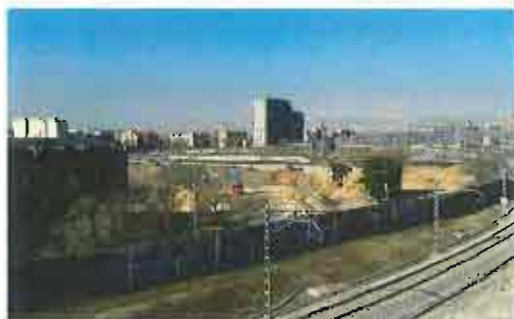
Zona límite del ferrocarril y la urbanización de la calle del Tejo: vista de la tapia de separación
