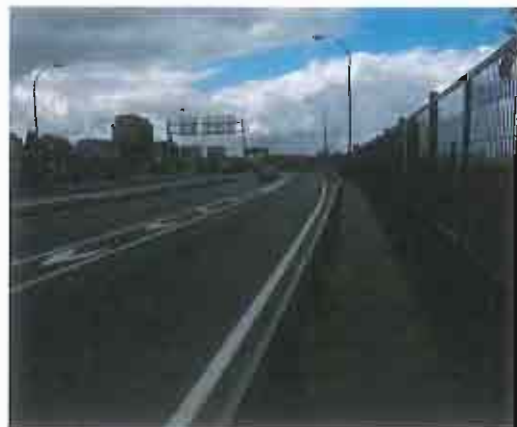
Vista del viaducto en su zona central: paso peatonal y valla de protección
