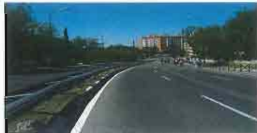
Visita al viaducto por Pedro Bosch
