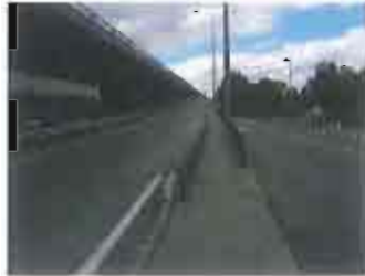
Acceso peatonal al viaducto
