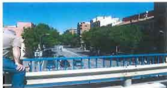
Visita al viaducto con vistas a la Avda. Ciudad de Barcelona
