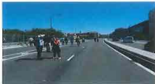
Visita al viaducto por la zona central
