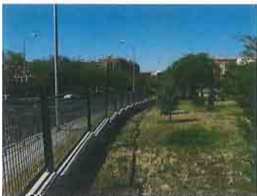
Linea límite de separación de la zona verde del colegio con el viaducto
