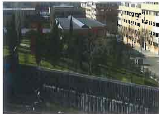
Zona límite de la zona verde, el colegio y la parte residencial de la calle del Tejo
