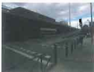
Rampa de acceso al viaducto desde la Avda. Ciudad de Barcelona
