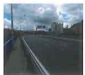
Vista de la parte alta del viaducto hacia el Distrito de Retiro
