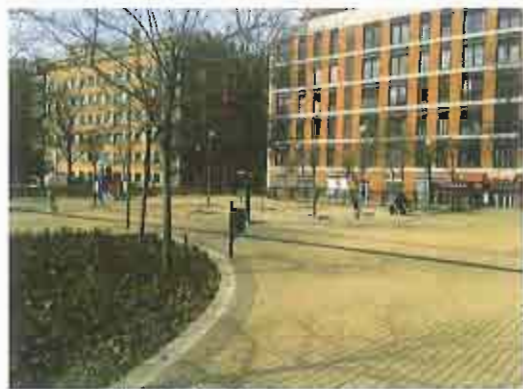
Vista Interior de la zona de Cocheras
