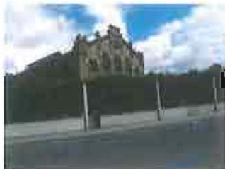
Edificio de Unión Fenosa en deficiente estado de conservación, también aislado
