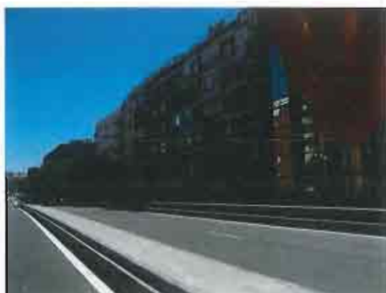
Vista de los edificios con problemas de ruidos (lateral derecho)
