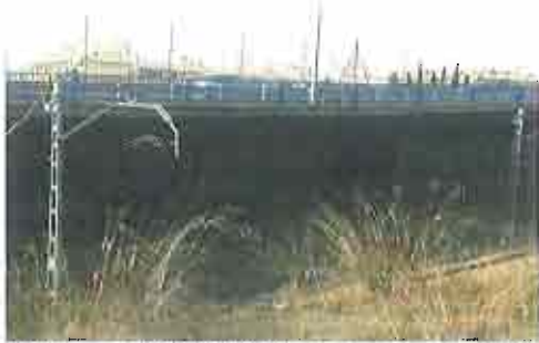
Línea de separación entre el viaducto y la zona intersticial por la vía ferroviaria de cercanías
