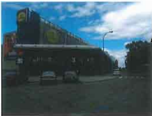
Vista del edificio de proyección cinematográfica
