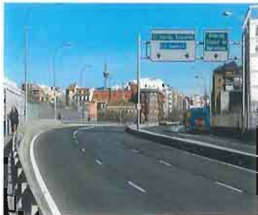
Vista del viaducto en su zona central: calzada y paso peatonal
