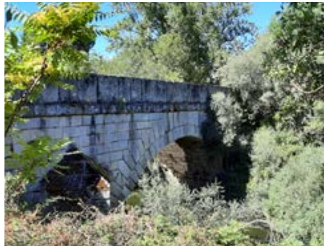
Puente nuevo o de Herrera, semioculto en la espesura
