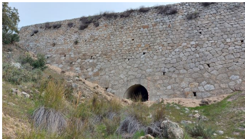
Muro de acompañamiento y alcantarilla, modelonº 2 de la colección oficial de 1922
